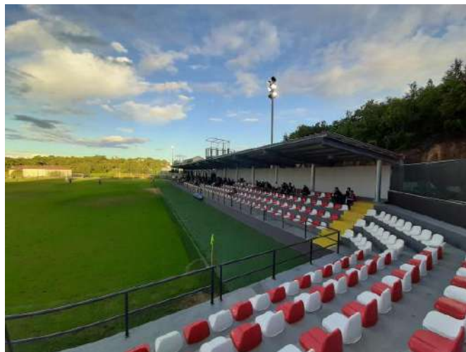
Slika: Novoizgrađena tribina na ŠRC "Marijan Šuto Mrma"
